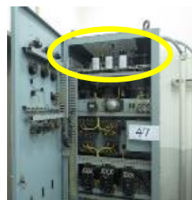
可変周波数電源装置に取り付けられた低圧コンデンサー
