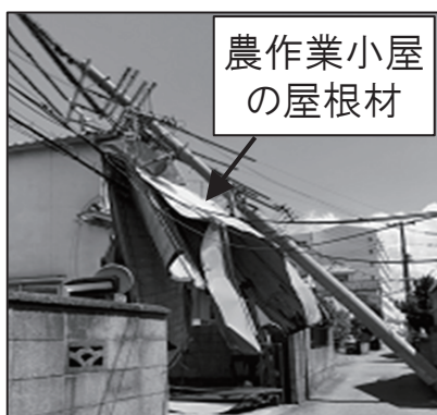
飛来物による電柱倒壊被害（平成30年台風21号）
