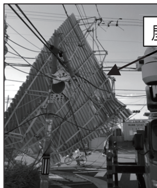
飛来物による電柱倒壊被害（平成30年台風21号）
