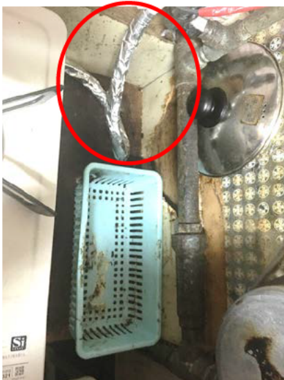
(復旧状況① ガス栓接続部側)
