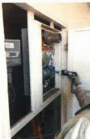
【ガス圧（給湯二次圧）測定の様子】
