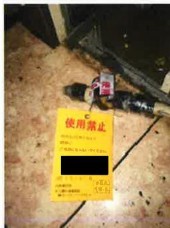
⇒当該コンロを取り外し、中間ガス栓側接続箇所のプラグ止め措置を実施
