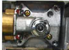
予備ガス栓周辺樹脂を全て外した状態
