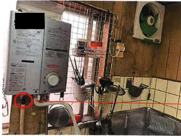
(機器設置状況)
