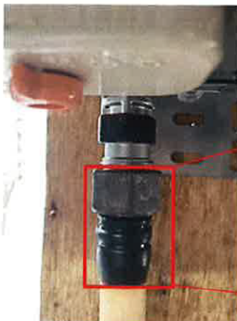
(ガス接続部材（ゴム管口）の状況)
