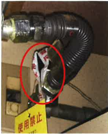
(応急措置状況)
