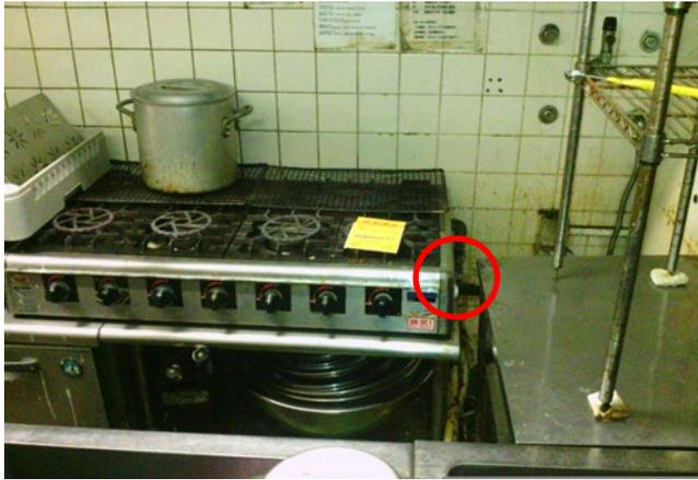
【機器接続具焼損箇所・漏れ箇所】
