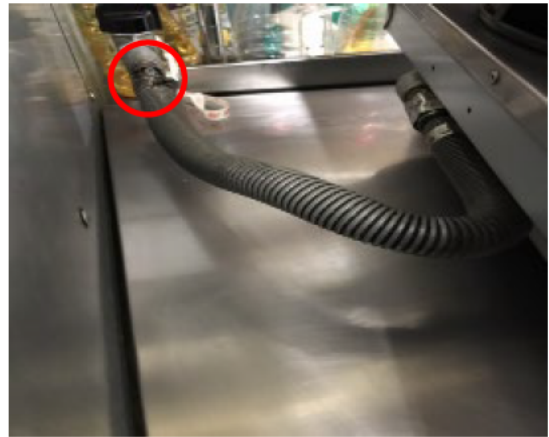
【接続具取替後（強化ガスホースへ取替）】
