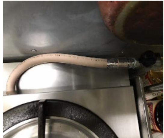
【接続具取替後（強化ガスホースへ取替）】
