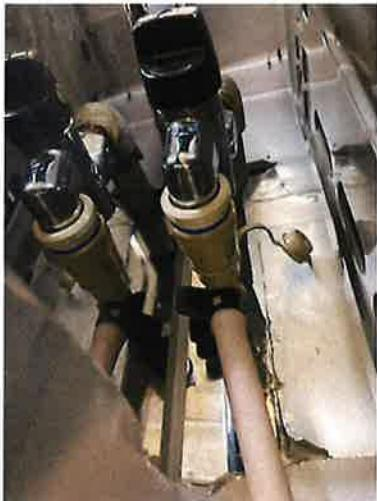
⇒迅速継ぎ手、ソフトコードおよびガス栓キャップの取り替えを実施
