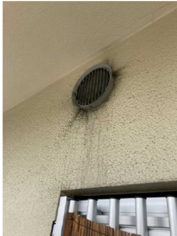
(排気ダクト先端の状況)
