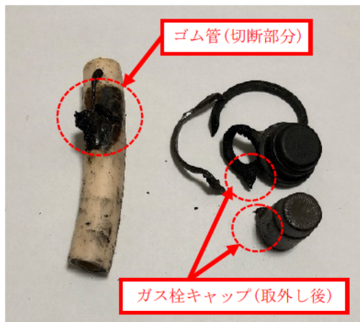
【ゴム管及びガス栓キャップ焼損状態】
