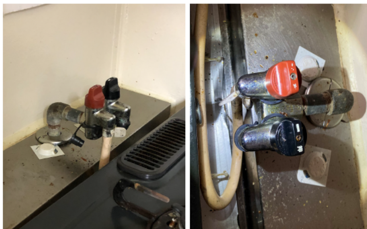
【復旧状況（ガス栓キャップ取替・ゴム管一部切断後接続）】
