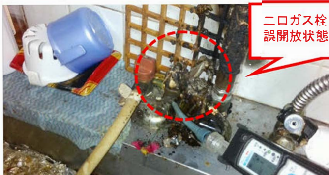
【瞬間湯沸器、強化ガスホース焼損状況】
