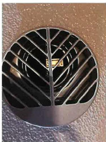
⇒防火ダンパーが設置され、排気熱によりダンパーが作動し排気筒が閉塞状態となっていることを確認。
