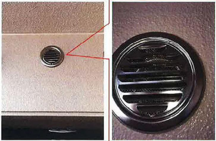
⇒防火ダンパーを取り外し、新たにガラリを取り付け
