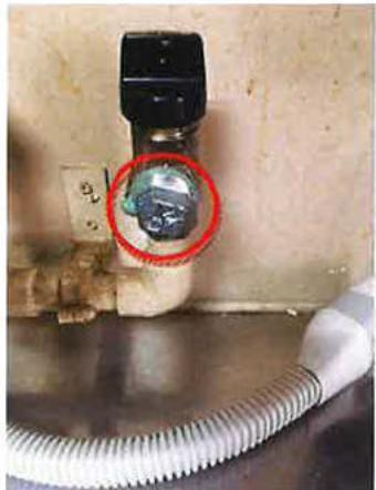
⇒強化ガスホースを取り外し、ガス栓のプラグ止めを実施
