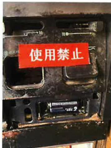
⇒キャビネット内にあるビルトインコンロのガス栓を閉止し、使用禁止措置を実施
