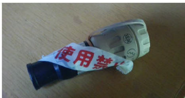
【使用禁止措置】(迅速継ぎ手 (ゴム管接続タイプ) 取り外し)
