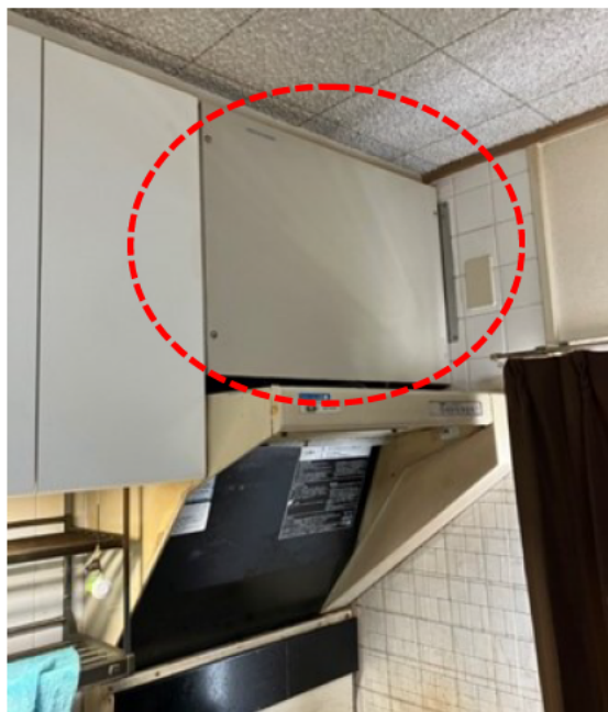
◆レンジフード上部内の給湯器設置状況
