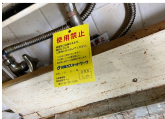
◆使用禁止措置(ガス栓部分)
