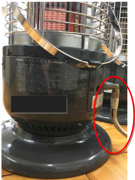
(復旧状況② (ガスコードへ取り替え))
