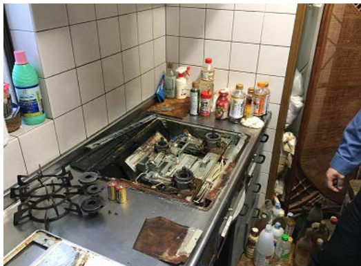
(機器設置状況 (コンロ天板部分取り外し済))
