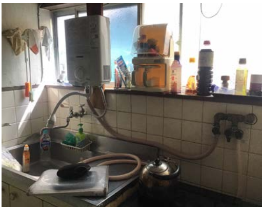
(復旧状況 (強化ガスホースにて接続))
