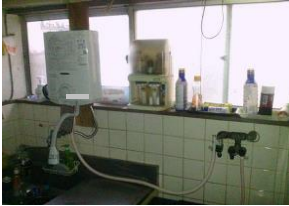
(機器設置状況)
