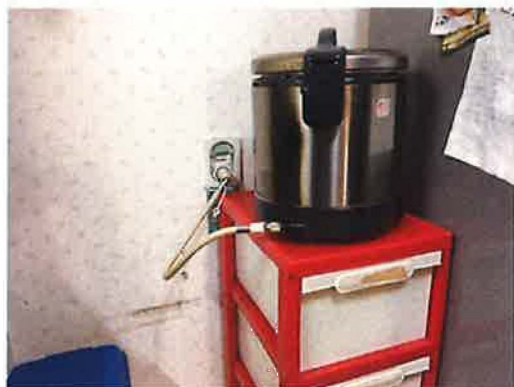
(機器設置状況)
