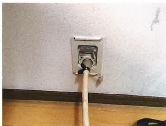
(ガス栓側接続状況 (壁コンセントガス栓))
