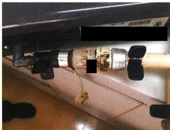
(ガス栓側接続状況 (壁コンセントガス栓))
