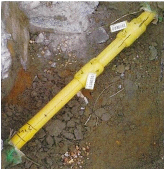
【復旧後の状況】
