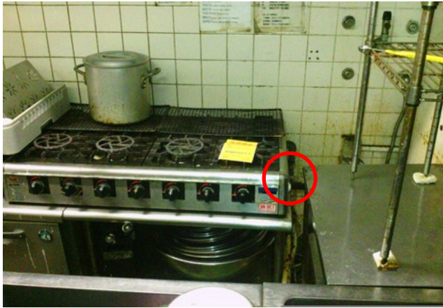
【機器接続具焼損箇所・漏れ箇所】
