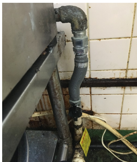
【金属可とう管取替後】
