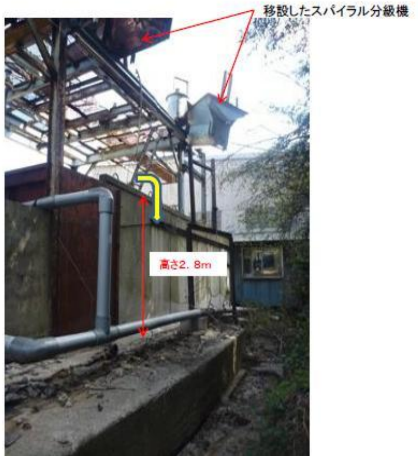
墜落現場(スターション上部から落下面まで2.8m)
