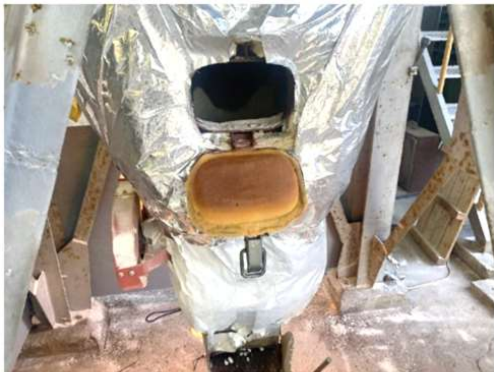
写真3：手を差し込んだ点検窓
