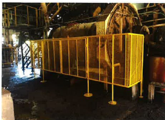
恒久対策後（全景）
