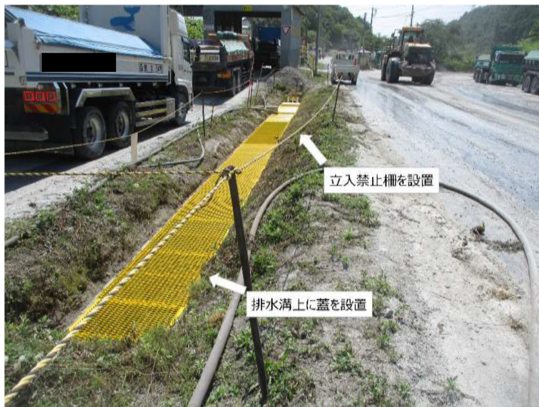
写真3 排水溝への転落防止の措置状況
