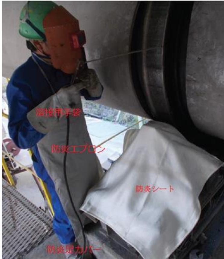
溶接作業時保護具、溶接作業箇所付近の可燃物等への防炎シートによる被覆
