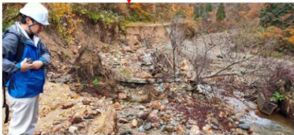
【上空写真と現場状況】
