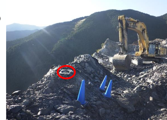
罹災者転落推定箇所
