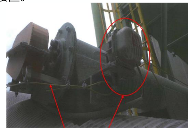
引き網 非常停止装置 非常停止装置及び引き網
